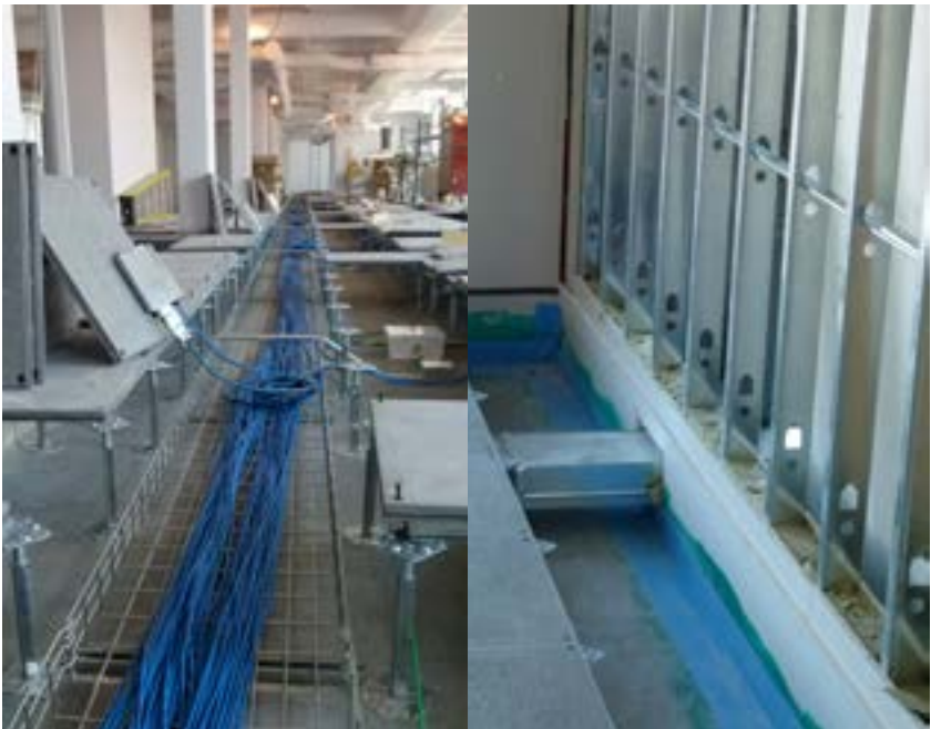
Installation du système de planchers surélevés.
