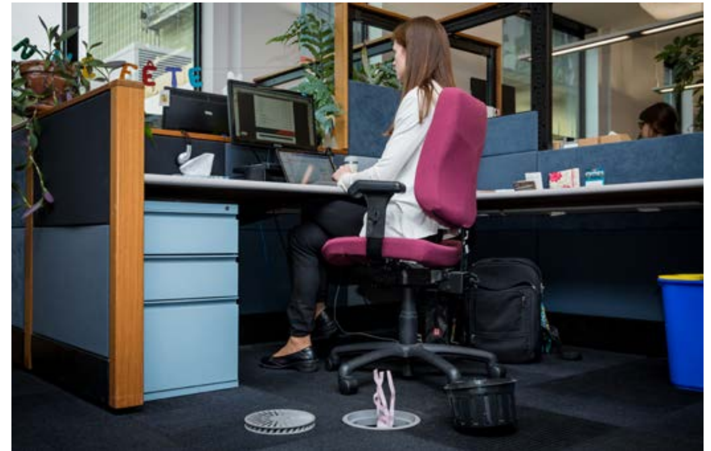
Mécanisme interne des diffuseurs. Photo : Antoine Saito.
