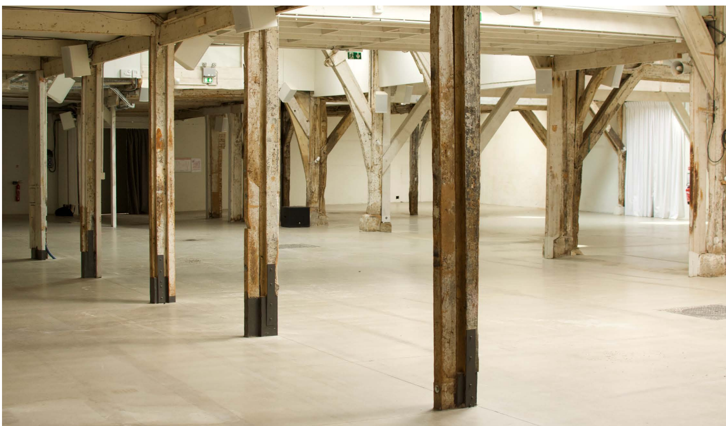
Grande halle actuelle - poteaux mezzanine (Pradel-Tessier, 2025)
