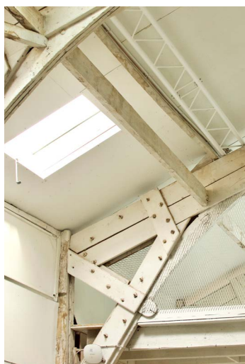
Assemblage ferme et panne
