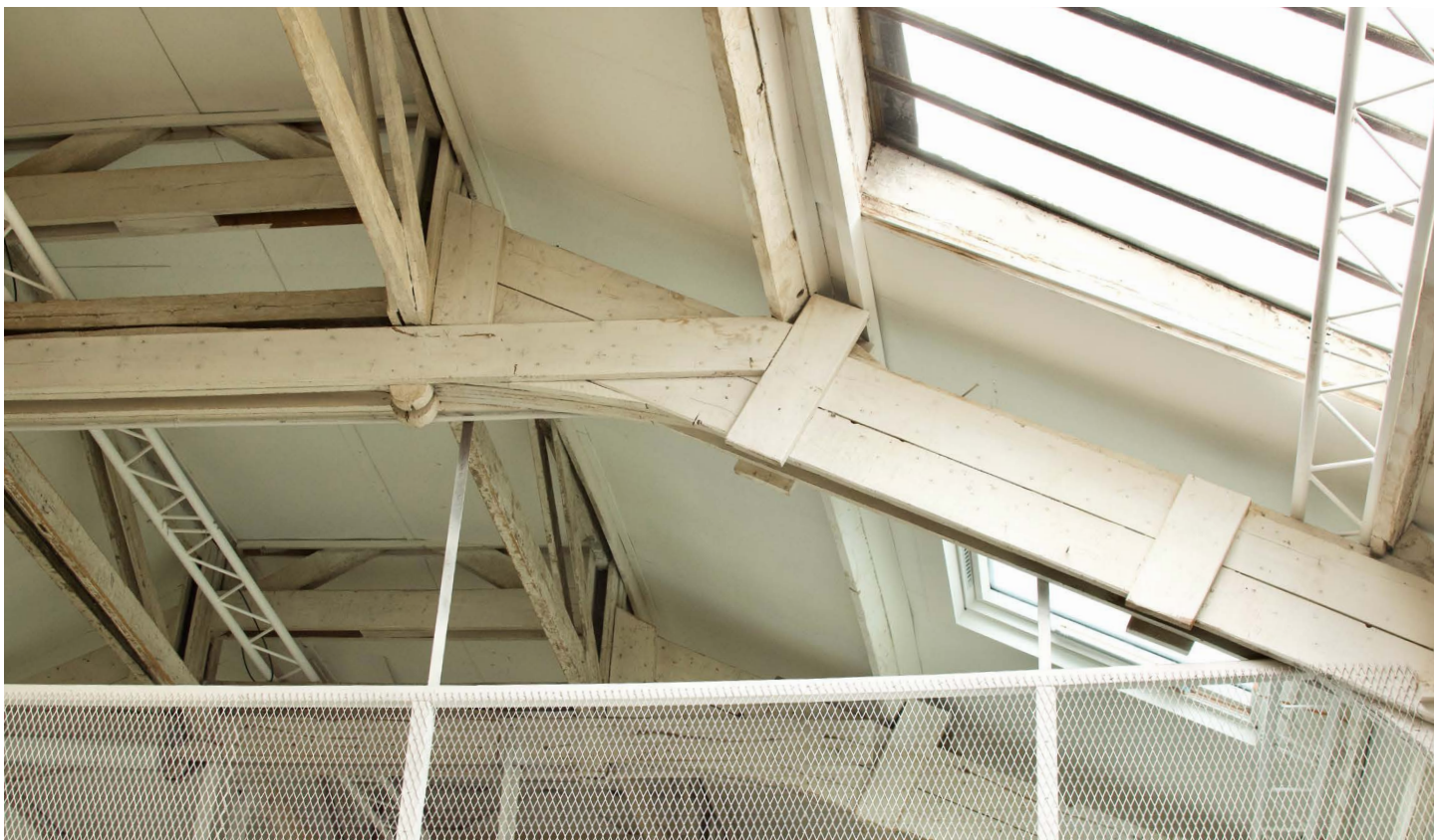
Grande halle actuelle - puits de lumière (Pradel-Tessier, 2025)
