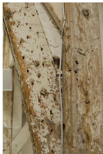
Assemblage par clous du «lamellé-collé»
