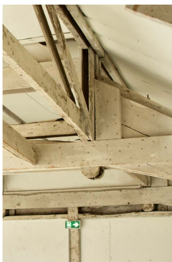
Assemblage ferme et poutre treillis
