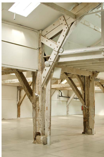
Ajout d'éléments de renfort et remplacement des assemblages (boulonnage)
