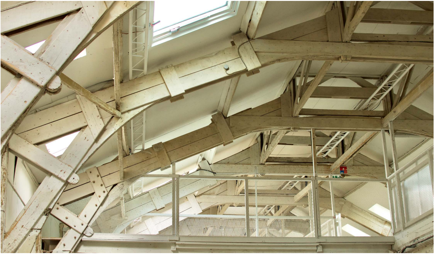
Grande halle actuelle - fermes, pannes et poutres treillis (Pradel-Tessier, 2025)
