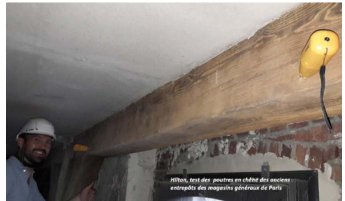
Test sur poutre (CBS-CBT, s.d.)
