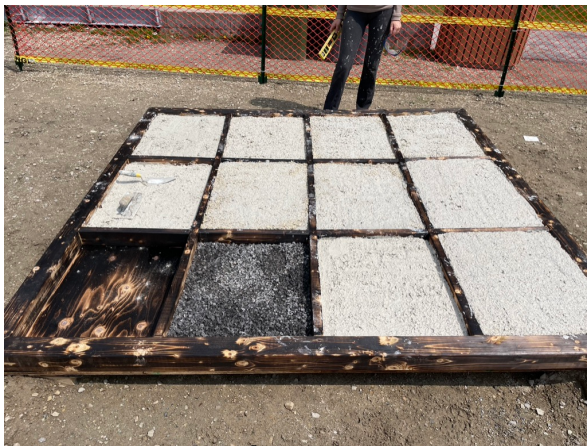
L'asphalte broyée et le compactage
