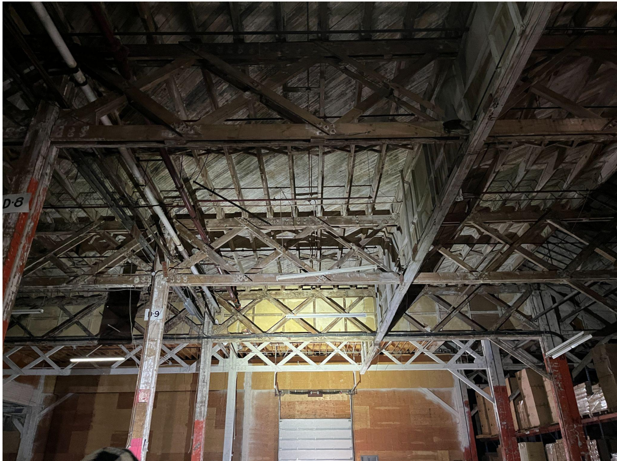
Charpente de bois visée
