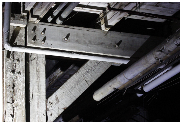
Assemblages boulonnés réversibles
