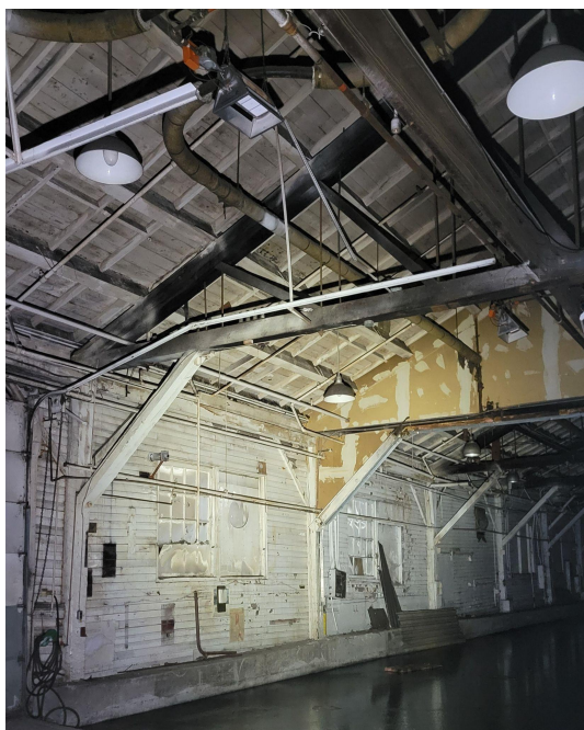
Conduits au plafond et mur extérieur
