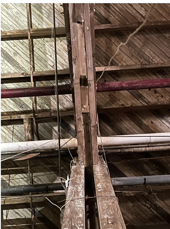
Jonction colonnes - fermes - conduits
